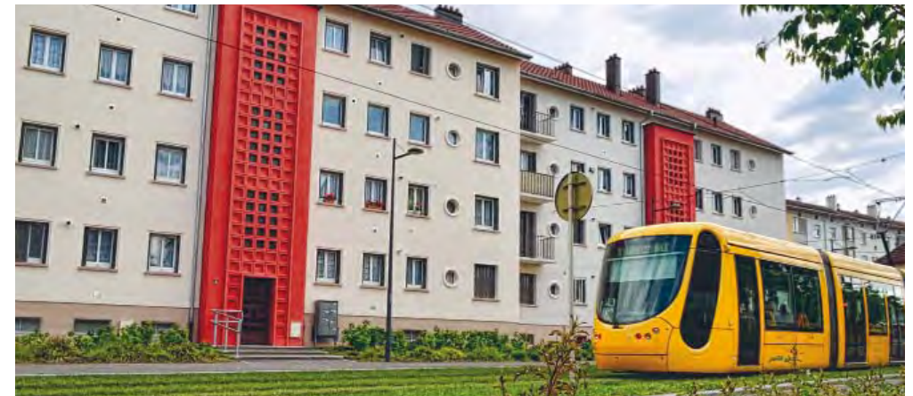
Réhabilitation d'un immeuble collectif des Mines de potasse d'Alsace. Archives SOMCO.
