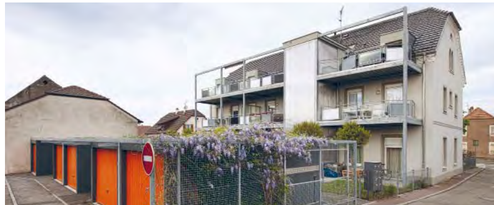
Réhabilitation de la mairie-école de Hombourg. Photo Marc Guénard
