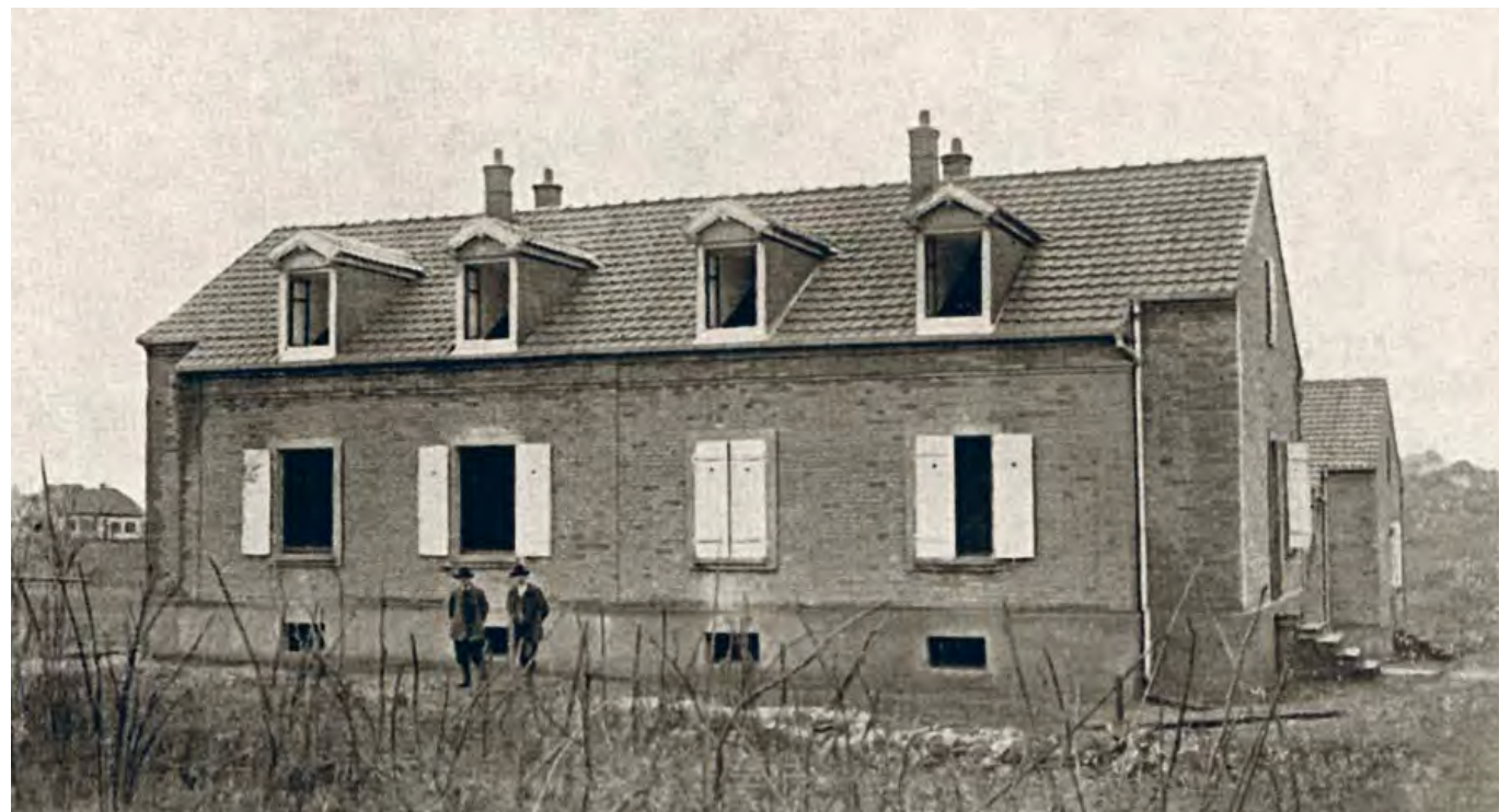
Maison construite en 1922 à l'Illberg, AMM, fonds SOMCO.
