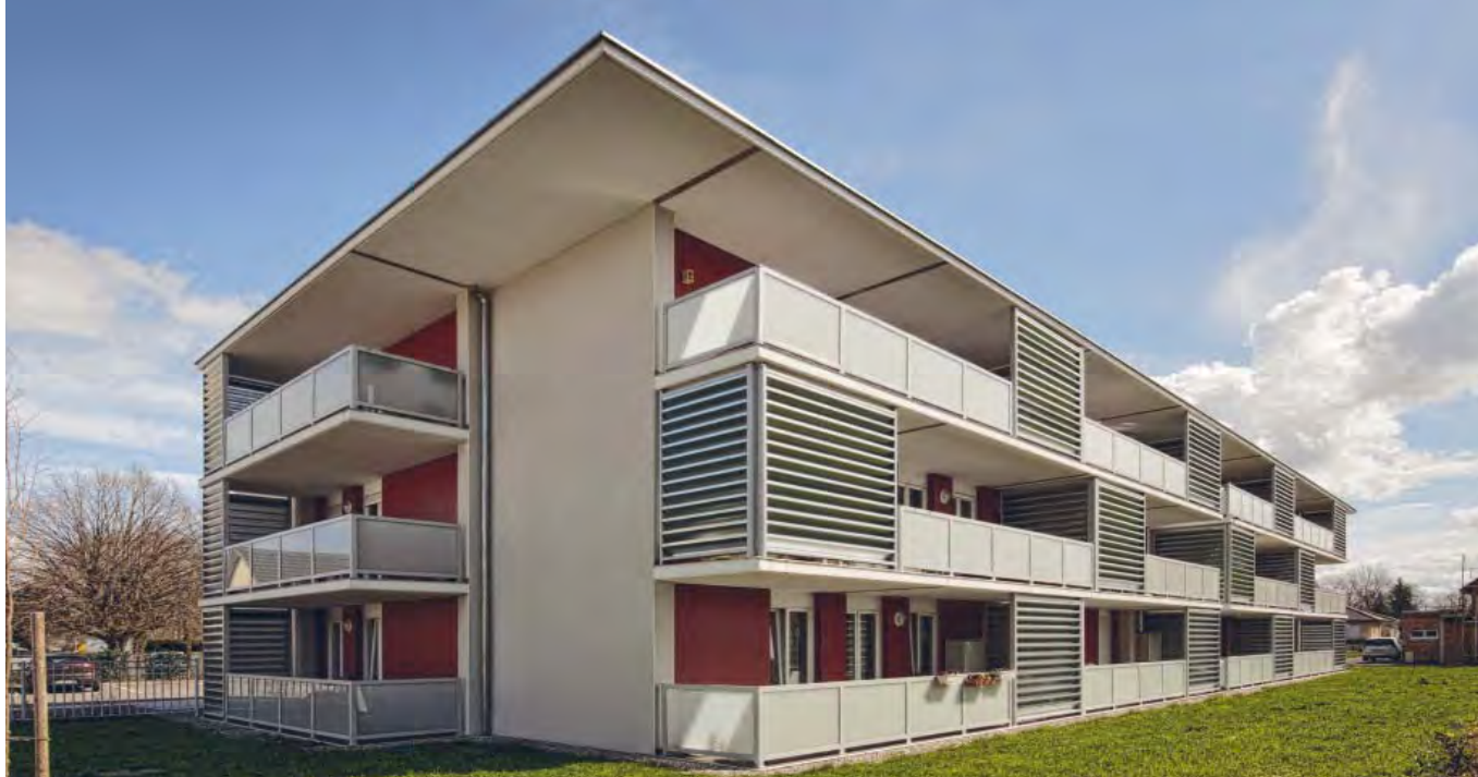
Réalisation de la résidence « Au clair de lune », rue des Vergers, Sausheim. Photo Marc Guénard.
