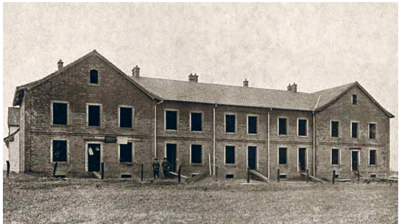
Maison à cinq logements construite à l'Illberg en 1927. AMM, fonds SOMCO
