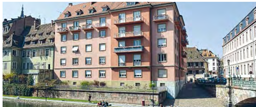
Réhabilitation rue de la Pierre-Large, Strasbourg. Archives SOMCO.
