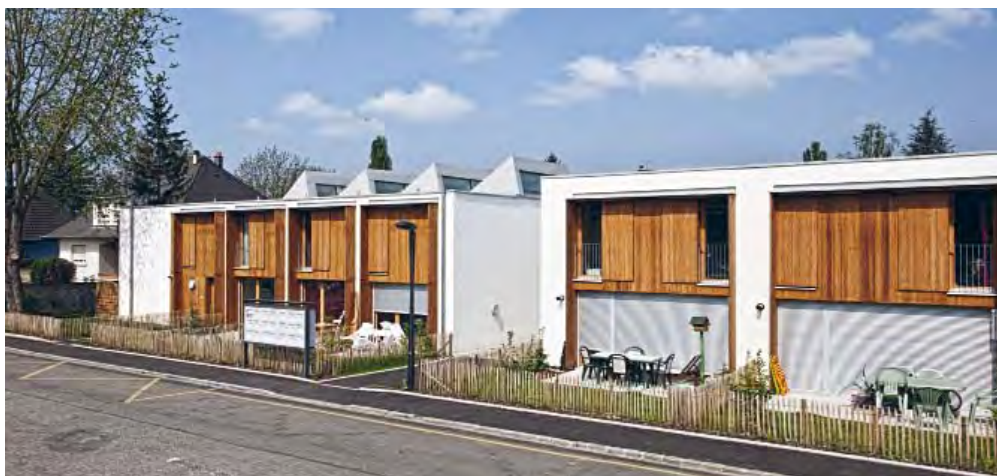
Réalisation de la rue Schweitzer, Riedisheim. Photo Marc Guénard.
