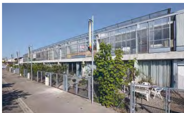
Vues extérieure et intérieure d'un logement de Lacaton-Vassal, photo. Marc Guénard et Philippe Ruault.
