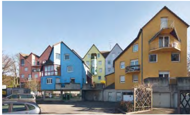
Réalisation de la brasserie, Lutterbach. Photo Marc Guénard.
