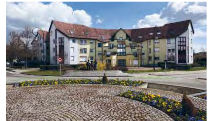
Réalisation de la rue des navettes, Sausheim. Photo Marc Guénard.
