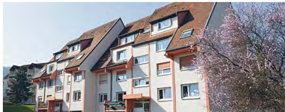
Réhabilitation rue de l'abattoir, Rosheim. Archives SOMCO.
