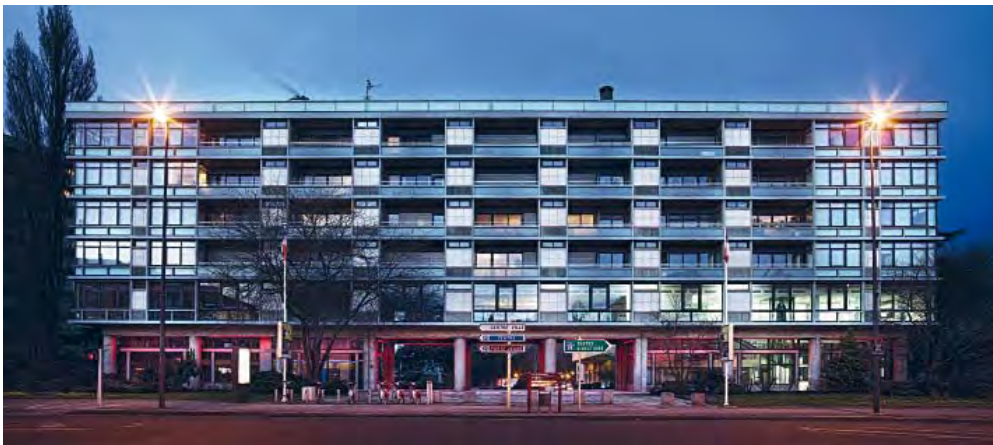
Réhabilitation de l'immeuble Ecran, Porte de Bâle. Photo Marc Guénard.
