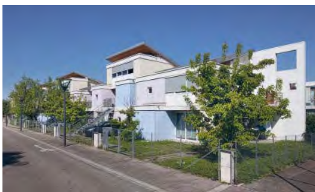
Vues extérieure et intérieure d'un logement de S. Ban, photo. Marc Guénard et Philippe Ruault.
