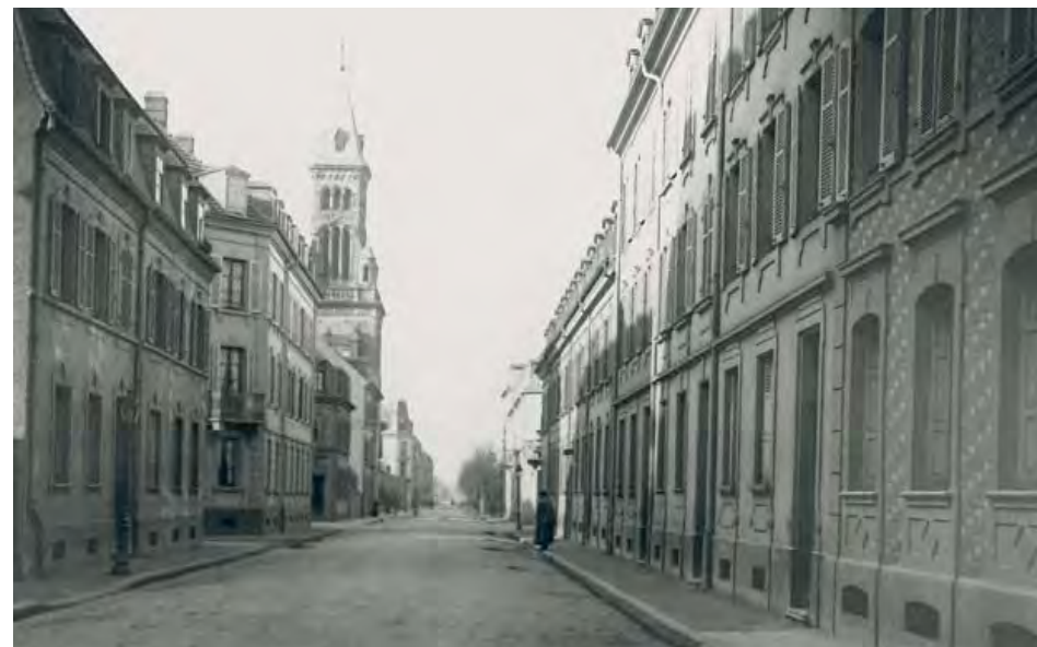
L'église Saint-Joseph en 1898. AMM. Les immeubles en R+2+C (ou R+1+C) construits par la caisse de crédit mutuel initiée par le « curé de choc » Henri Cetty bordent la Cité. L'église Saint-Joseph, consacrée en 1883, est la paroisse catholique de la Cité.
