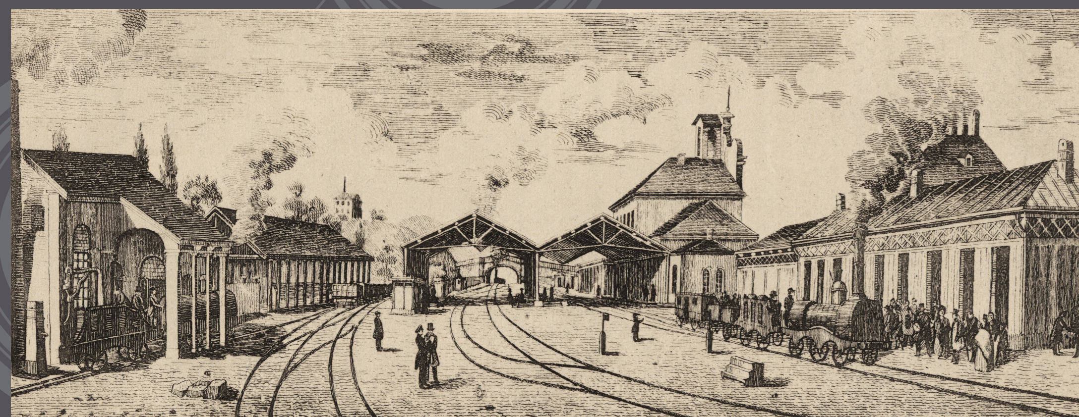
La station, vue des voies, en 1842. À gauche, l'approvisionnement en eau et en combustible des locomotives, à droite une remise pour les voitures; dans le lointain, la villa du Hasenrain. [Cliché Ad. Braun & Cie, in William Grosseteste, Chemin de fer de Mulhouse à Thann. Notes et documents, Mulhouse, 1889, BUSIM]
