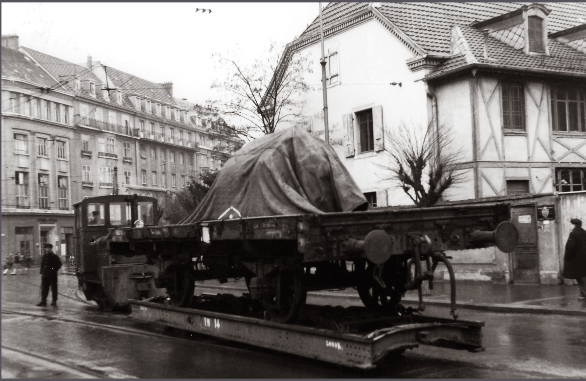
Au début du XX e siècle, dans la rue du Barrage (bd. de l'Europe), transport d'un wagon plat par truck sur le réseau du tramway à voie étroite. [Photo Soléa]
