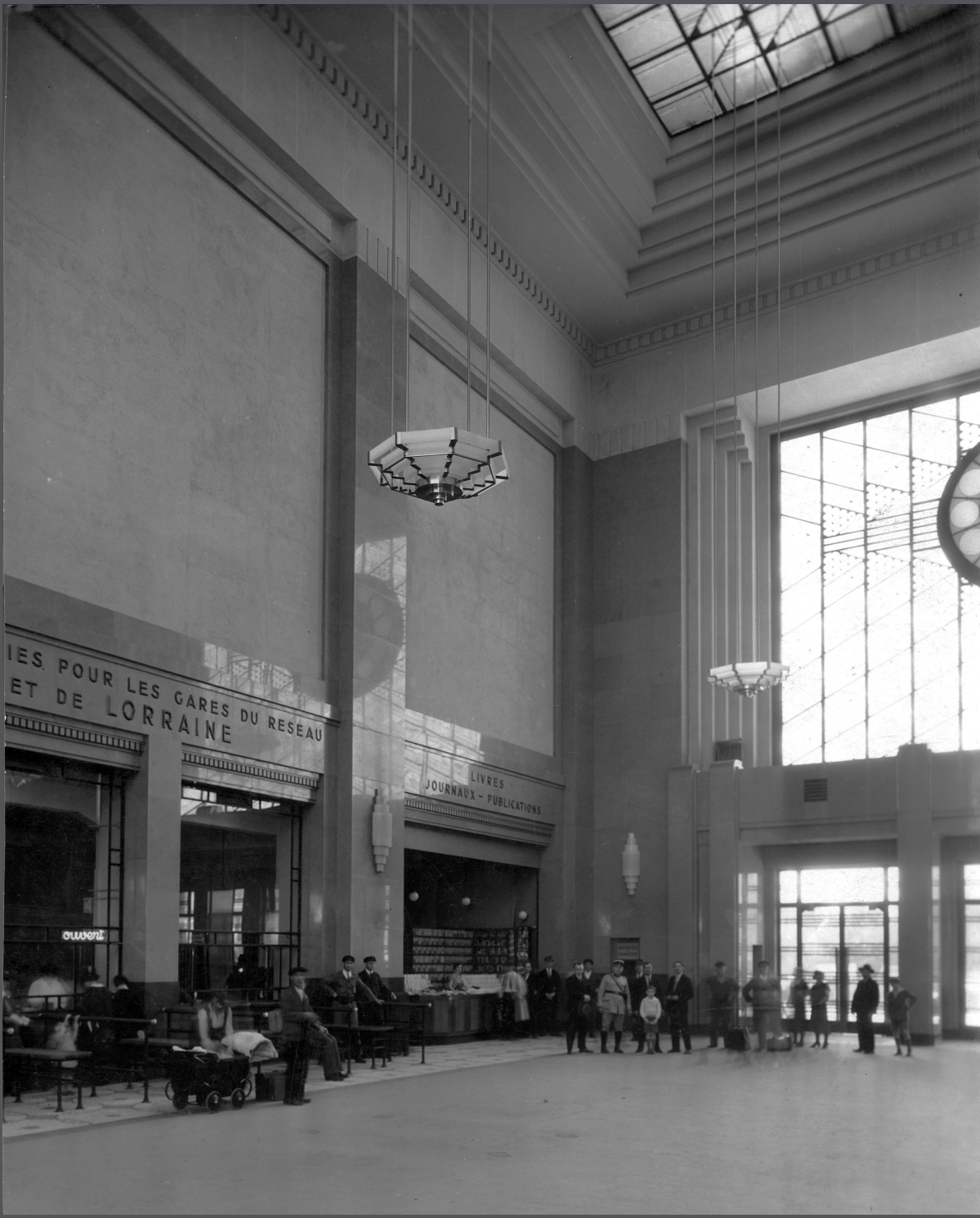
Le hall de départ avec les guichets pour le réseau Alsace-Lorraine, le bureau de tabac et le kiosque à journaux. Des fresques étaient prévues sur les panneaux muraux. (Photo Studio Roger, in Albert Laprade, «La gare de Mulhouse».L' Architecture française, 1934, AM).
