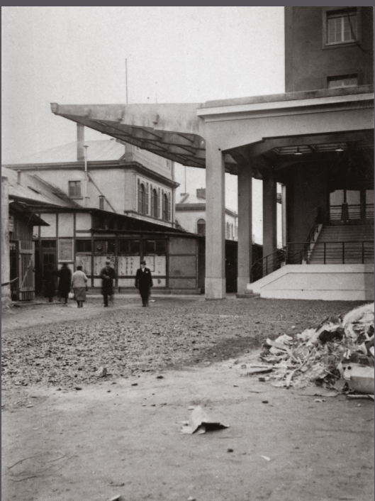
La nouvelle gare est construite à l'avant de l'ancienne gare qui reste en service jusqu'en 1933; sa structure est en béton armé, recouvert d'un parement de grès rose. (Photos Studio Roger, collection Gerrert)
