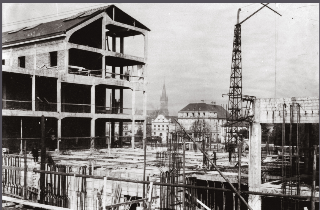
La nouvelle gare est construite à l'avant de l'ancienne gare qui reste en service jusqu'en 1933; sa structure est en béton armé, recouvert d'un parement de grès rose. (Photos Studio Roger, collection Gerrert)
